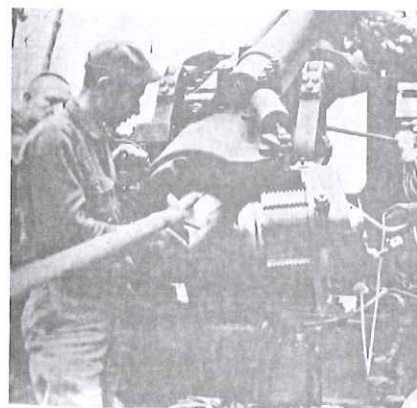
Carga de saco en obús de 155 mm Americano
