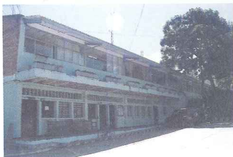
Pabellón de comando Batallón "Galán"
